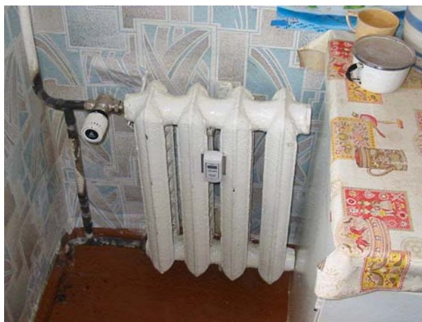
Рис. 2. Радиаторный распределитель тепла и термостатический регулятор в квартире жилого дома
